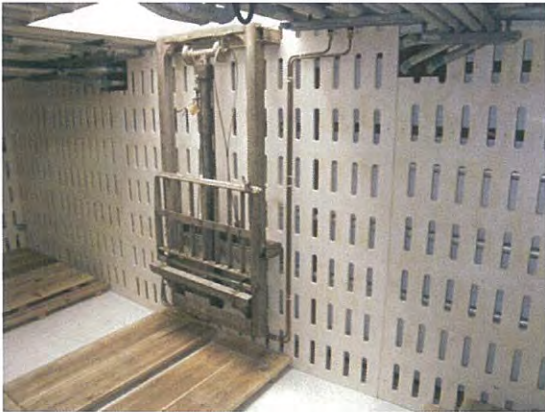
トロバコリフター全景(魚倉内)
